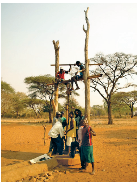
Fot. 1. Mieszkańcy wioski Simwange naprawiający zapadniętą studnię (fot. Dariusz Skonieczko)
